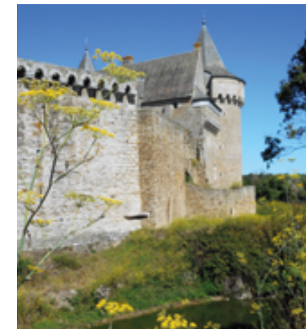
Fig. 3 – Vue extérieure de la chambre de tir de l'est, à la jonction entre les pans A et B. © Cliché Patrick André
