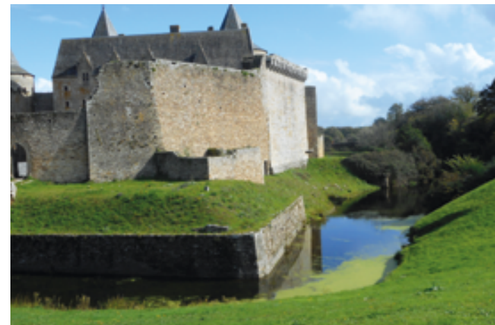
Fig. 2 – Le front sud du château, vu depuis l'ouest. Au premier plan, baigné par la douve, un bastion de la fin du xvi e siècle, au pied du pan C de la courtine. Au centre, le pan B et son couronnement de mâchicoulis. Au-delà, en saillie sur le pan B, le pan A. © Cliché Patrick André
